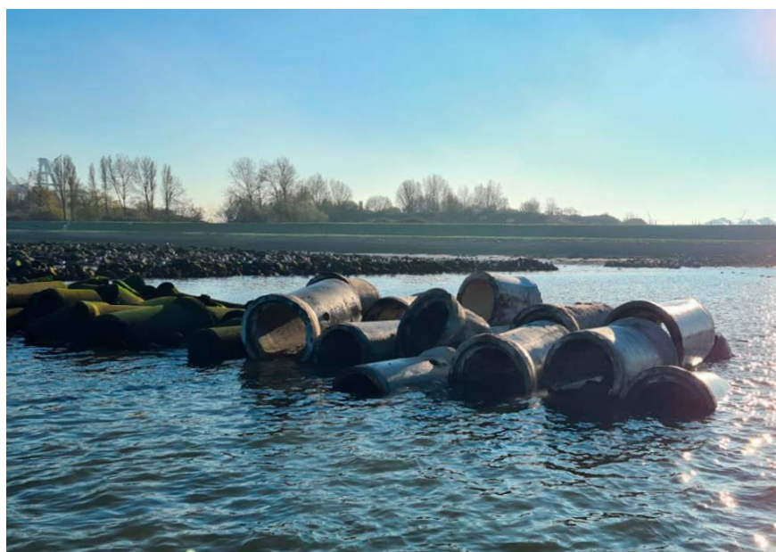
Delen van oude Rotterdamse rioolbuizen liggen langs de oever van de Nieuwe Waterweg, waar ze een langsdam vormen, waarachter een luwe gebied ontstaat | Rijkswaterstaat
