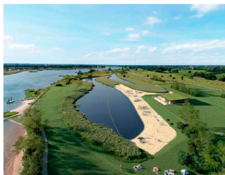
In de uiterwaard van Salmsteke hebben we een getijdengeul aangelegd en rivierhout geplaatst | Ton van Es
