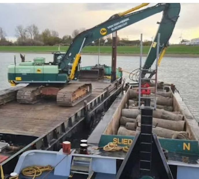
Riooldammen in de Nieuwe Waterweg – een kraan schept de oude rioolbuizen uit een schip | Van den Herik
