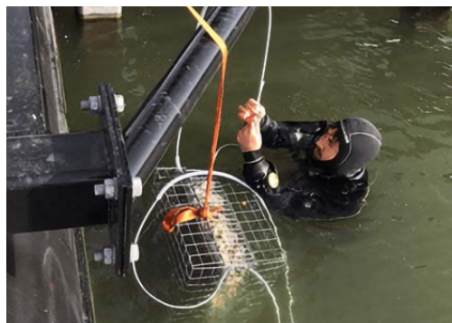
Een duiker controleert de geplaatste biohutten bij de overnachtingshaven in Bergambacht | Etienne Abadie, Ecocean
