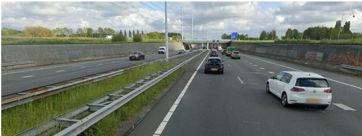
Figuur 5-45: Situatie ter plaatse van de noordelijke toerit met de gewapend betonnen bakconstructie. (bron: Google Earth).
