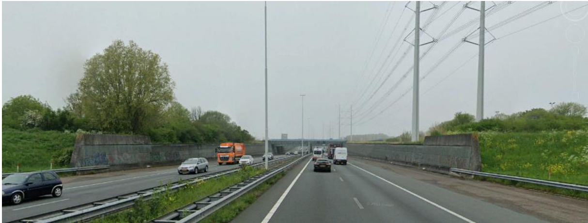
Figuur 5-44: Situatie ter plaatse van de zuidelijke toerit met de gewapend betonnen bakconstructie. (bron: Google Earth).
