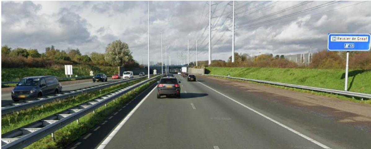
Figuur 5-23: Situatie ter plaatse van de zuidelijke toerit met de folieconstructie en groene taluds. Op de achtergrond de open bak met trekelementen (bron: Google Earth).
