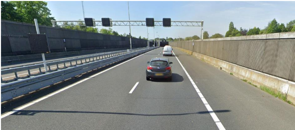
Figuur 5-86: Situatie ter plaatse van de noordelijke toerit richting het zuidwesten gezien. Op de achtergrond het gesloten deel (bron: Google Earth).
