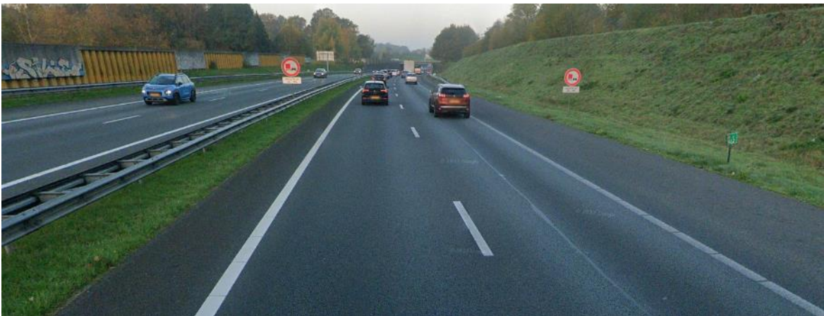
Figuur 5-3: Situatie ter plaatse van de oostelijke toerit richting het westen gezien. Op de achtergrond de open bak van gewapend beton (bron: Google Earth).
