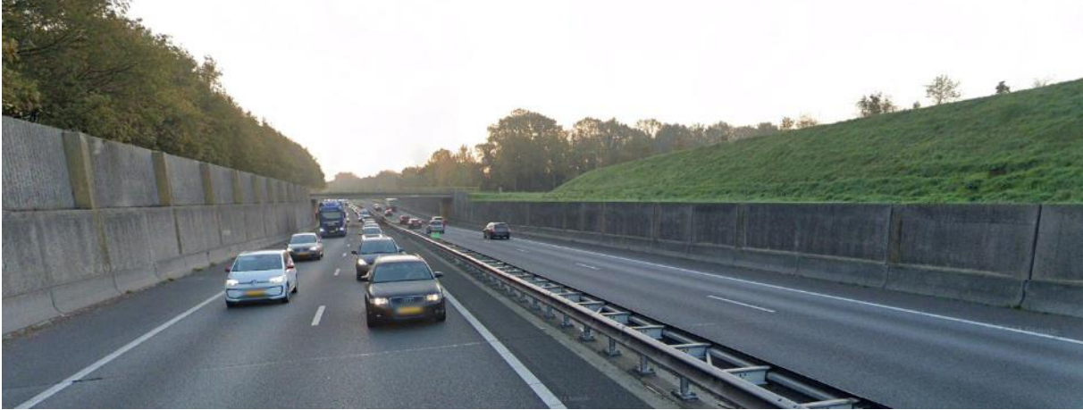
Figuur 5-65: Situatie ter plaatse van de westelijke toerit richting het oosten gezien. Op de achtergrond de open bak van gewapend beton (bron: Google Earth).
