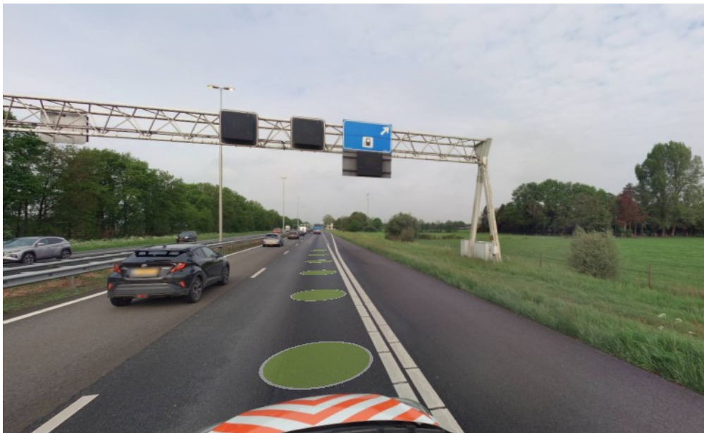
Km 48,7 aanduiding en begin uitvoeger naar de verzorgingsplaats
