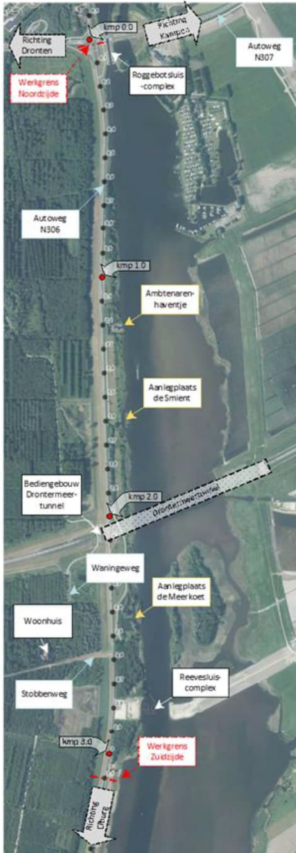
Figuur 6: Bestaande situatie Drontermeerdijk
