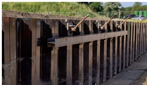
Foto 2: Proeftuin met groutankers
