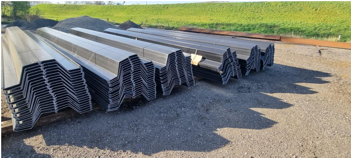
Figuur 7 - In elkaar geschoven dubbele damwandprofielen
