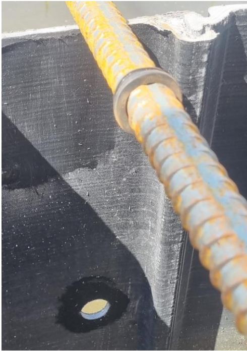
Figuur 18 - GEWI-ankerstang met rubberafdichting. Gat in damwand afgewerkt met Polylak Iso Npg
