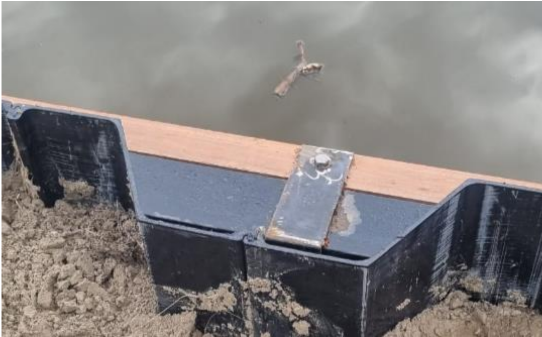
Figuur 24 - Houten wrijfging bevestigd voor kunststof gording middels beugel
