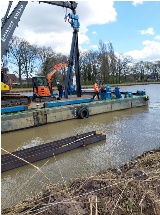
Figuur 9 - Inhijsen kunststof damwand in moederplank
