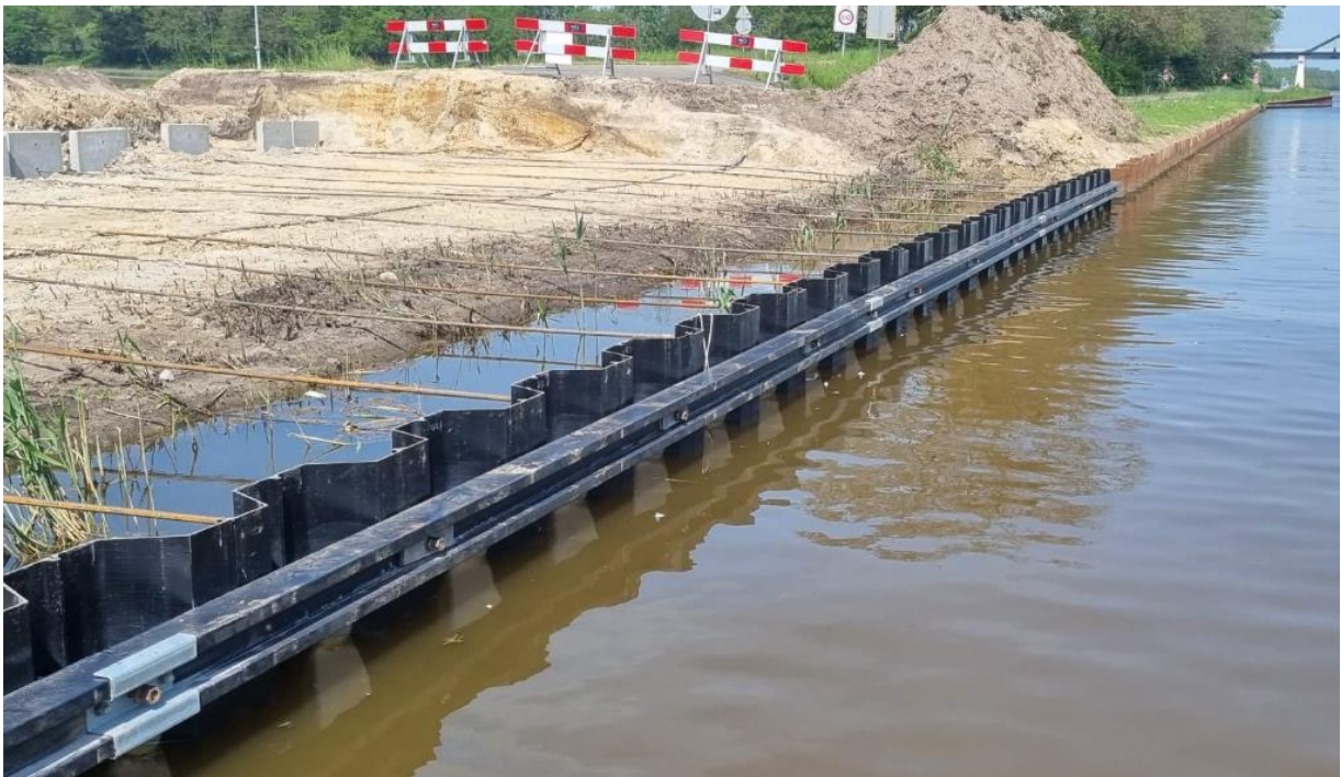
Figuur 21 - Aangebrachte legverankering
