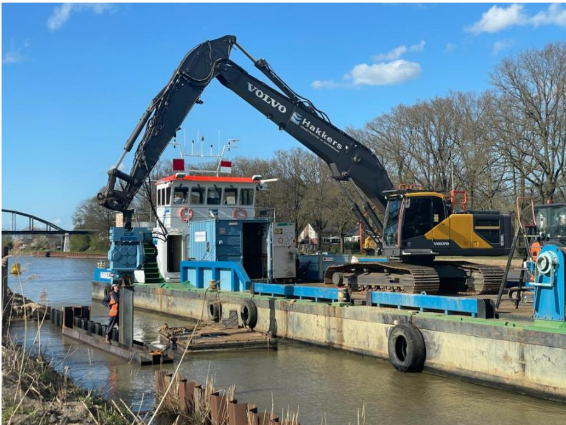
Figuur 4 - Aanbrengen kunststof damwanden vanaf de MS Dielis
