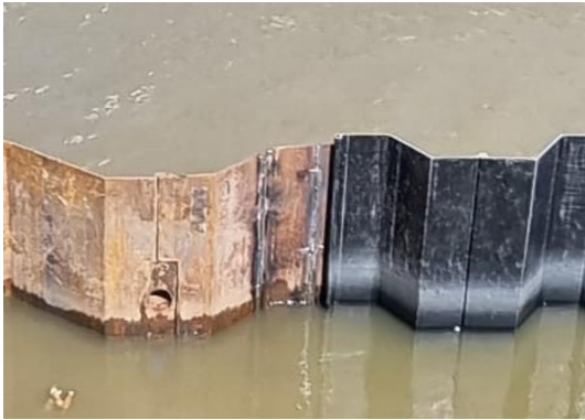
Figuur 14 - Aansluiting kunststof damwand op stalen damwand (noordzijde)
