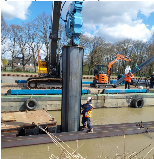
Figuur 12 - Aanbrengen damwand
