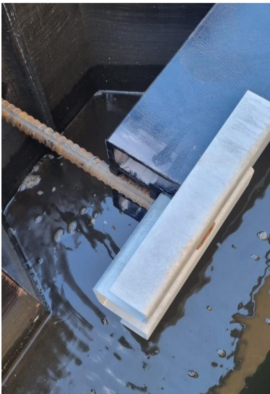
Figuur 19 - Kunststof gording (Super Wale) met W-splice en ankerstang. Uiteinde gording afgewerkt met Polylak Iso Npg.
