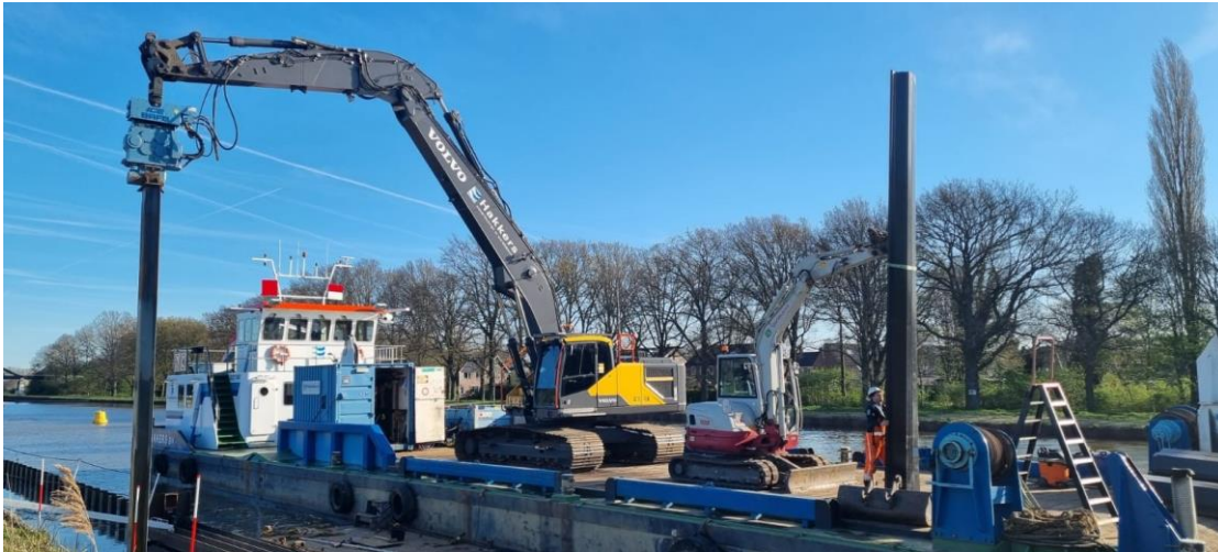
Figuur 3 - MS Dielis met Volvo 300 en hulpkraan tijdens aanbrengen kunststof damwanden
