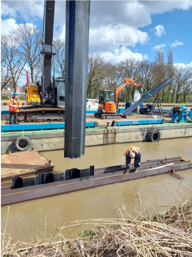
Figuur 11 - Inhijsen damwand in heigording
