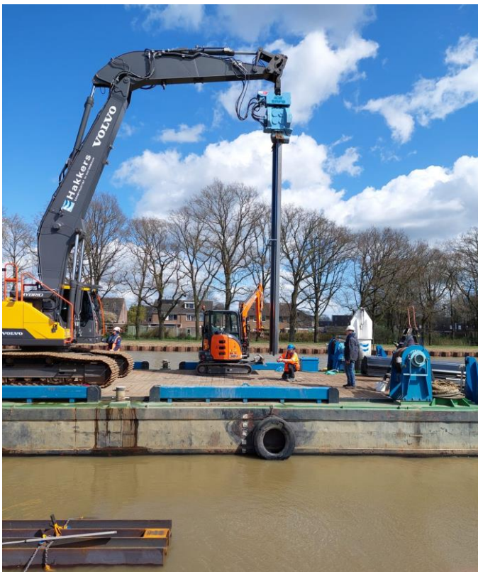
Figuur 10 - Aanbrengen clips
