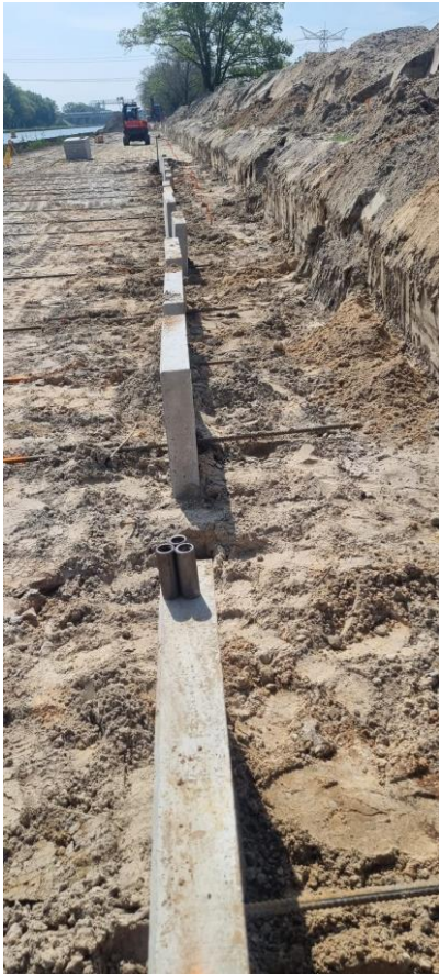
Figuur 20 - Ankerschotten in open ontgraving
