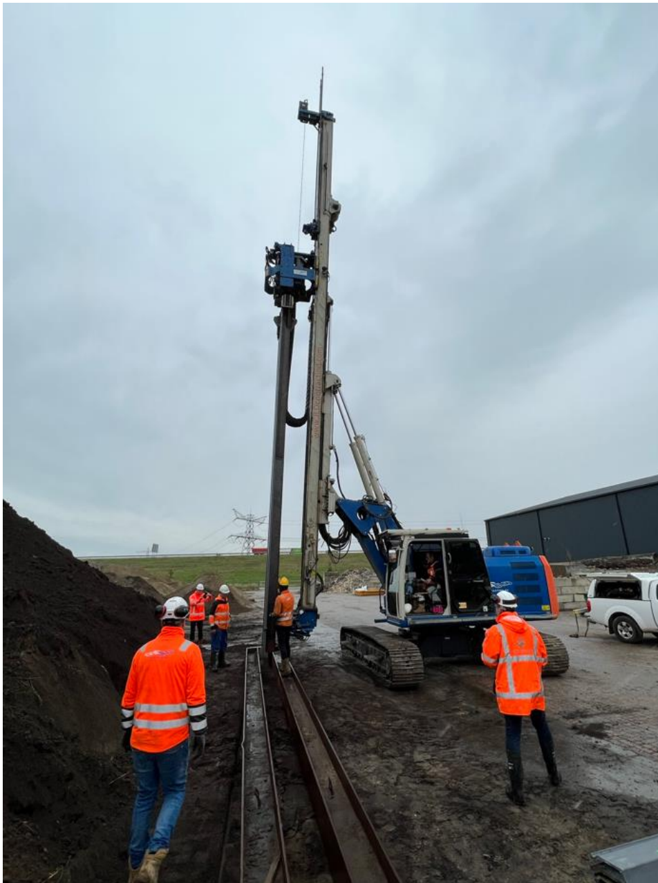
Figuur 3 – KLEMM KR2522 voorzien van makelaar en MOVAX SG-45G
