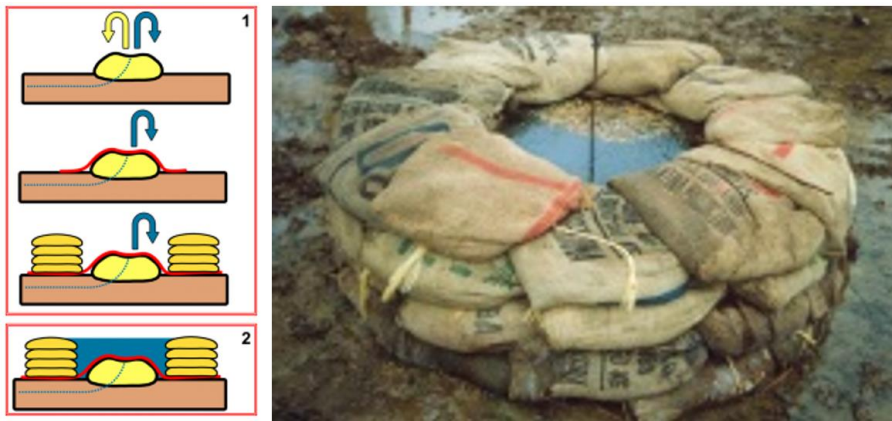
Figuur 4-6: Schematische weergave (links) en praktijkvoorbeeld (rechts) van opkisten van zandmeevoerende wiel (Bron: https://v-web002.deltares.nl/ )
