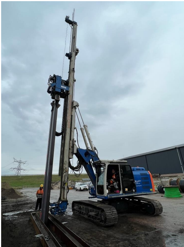
Figuur 8 - Hydraulische kraan met makelaar en trilblok
