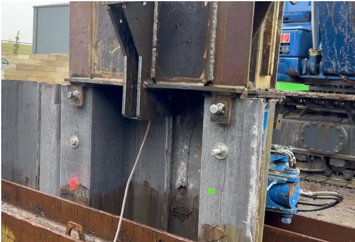
Figuur 12 - Kunststof damwandplank middels bouten bevestigd aan stalen moederplank t.b.v. trekken
