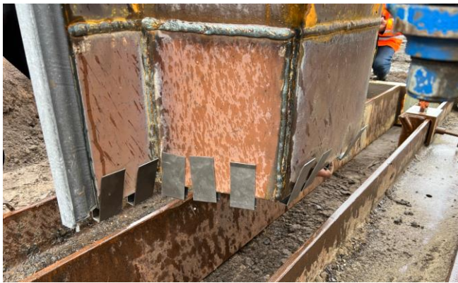
Figuur 7 - Kunststof damwandplank middels clips bevestigd aan de stalen moederplank
