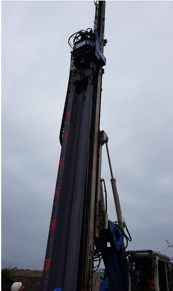
Figuur 9 - Damwandplank voorzien van maatstrepen
