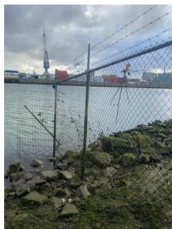
Figuur 2: Hekwerk op het talud
