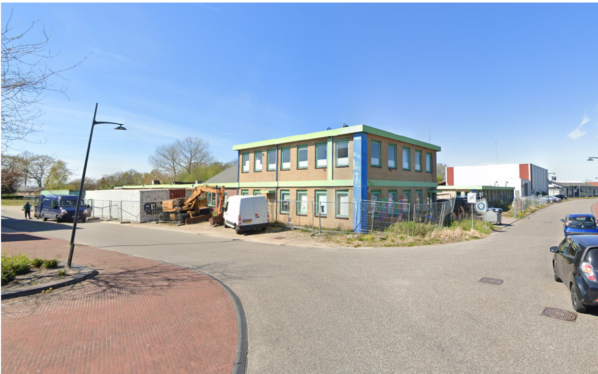
Figuur 2.4: Zicht op de (leegstaande) bedrijfsbebouwing richting het noorden, vanaf de zuidwestelijke hoek van het plangebied (bron: Google Streetview, d.d. 01-04-2022)
