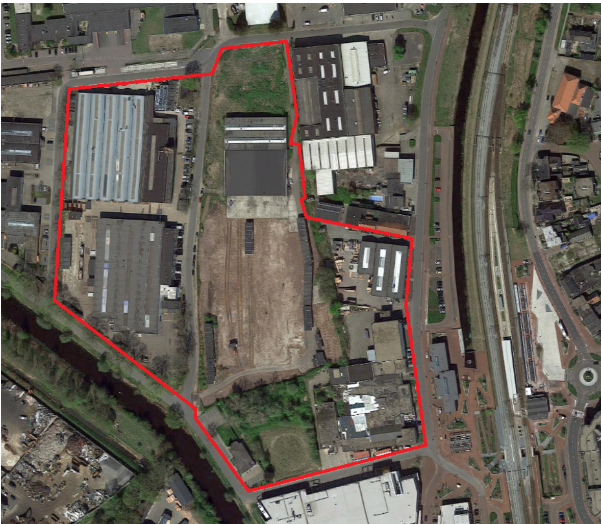
Figuur 2.1: Luchtfoto huidige situatie (bron: Google Maps)
