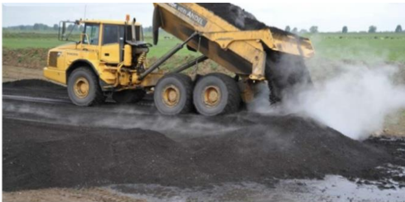
Figuur 2.3 Aanbrengen van TGG in het project Overdiepse polder. Het materiaal lijkt nog warm
