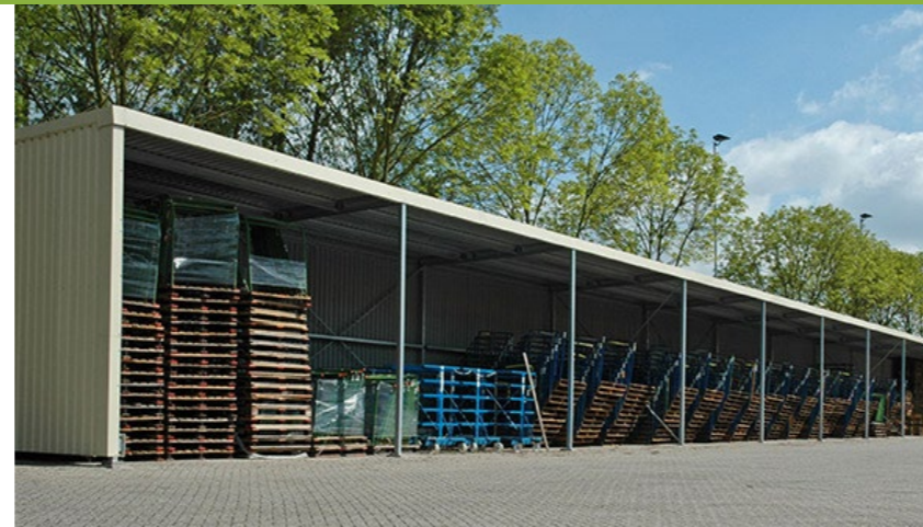
Afb. 25 b: open opslag binnen de toegestane voorwaarden aan het zicht onttrekken door afscherming (voorbeeld).
