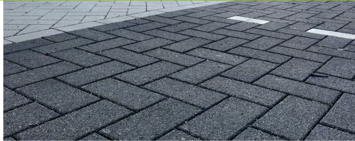
Afb. 23: voorbeeld passende terreinverharding voor oprit en terrein: betonklinkers in grijs/antraciet (ingetogen kleurenpalet).
