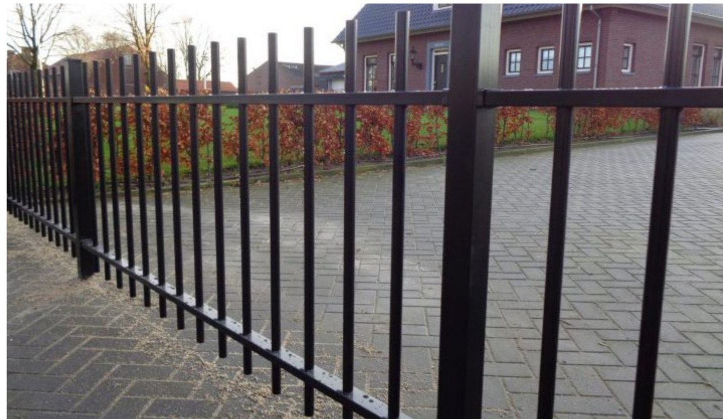
Afb. 24: uniforme keuze voor antraciete hekwerken (bijvoorbeeld: RAL7016) van gelijke hoogte (minimaal 2,0m).
