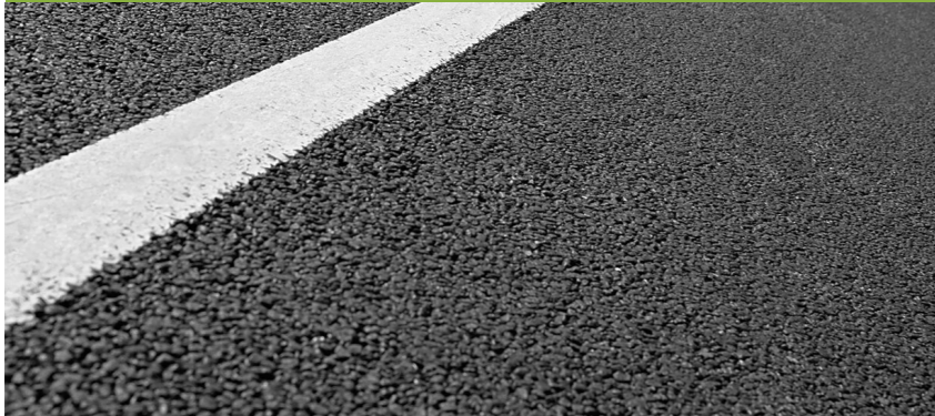
Afb. 7: Functionele uitvoering van de hoofdwegen in asfalt.
