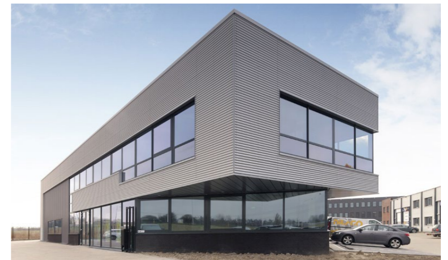
Afbeelding 15 a, b en c: voorbeelden van extra aandacht voor de stedenbouwkundige hoekaccenten door een verbijzonderde architectuur aan beide gevelzijden.
