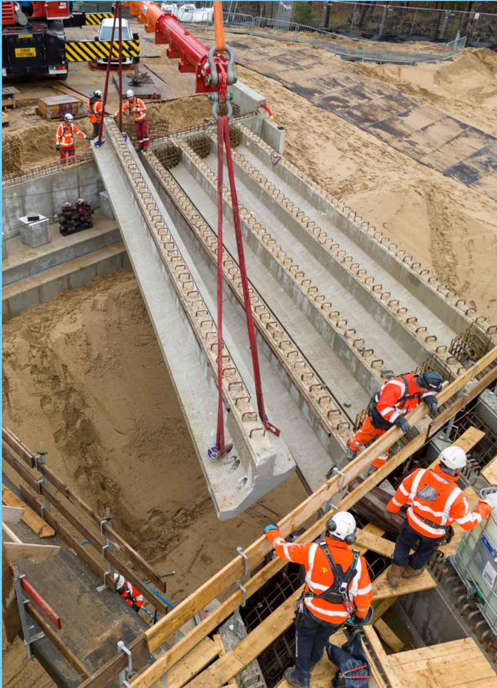
Hergebruik van liggers uit Ring Zuid bij Groningen in het viaduct in de A1 bij Hoog Burel
