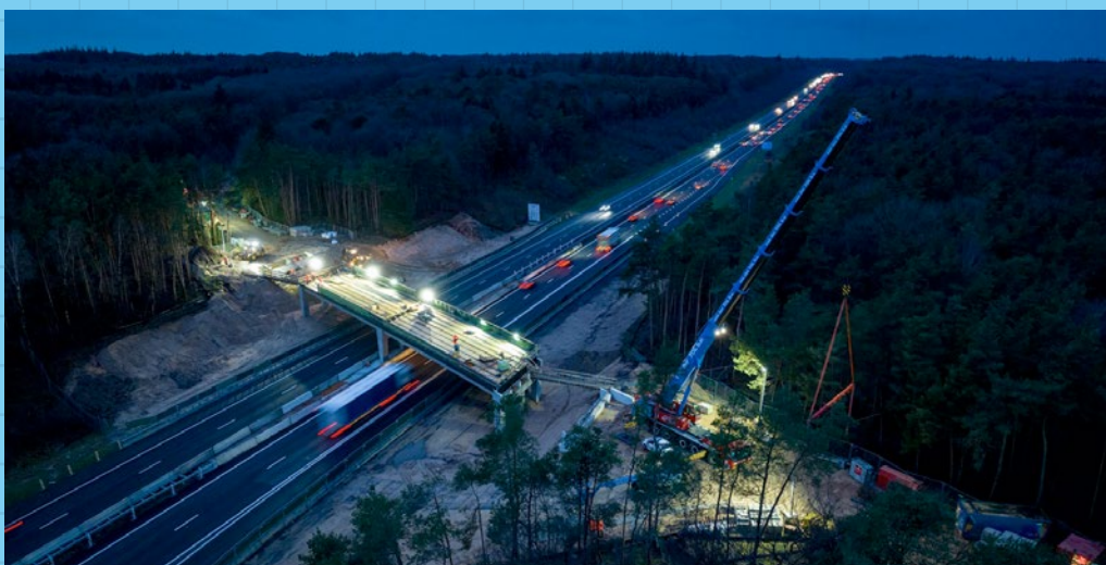
Hergebruik van liggers in het viaduct in de A1 bij Hoog Burel
