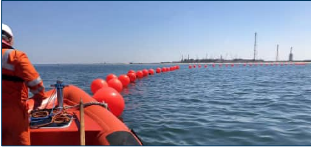
Figuur 20: Werkzaamheden vanuit een rib
