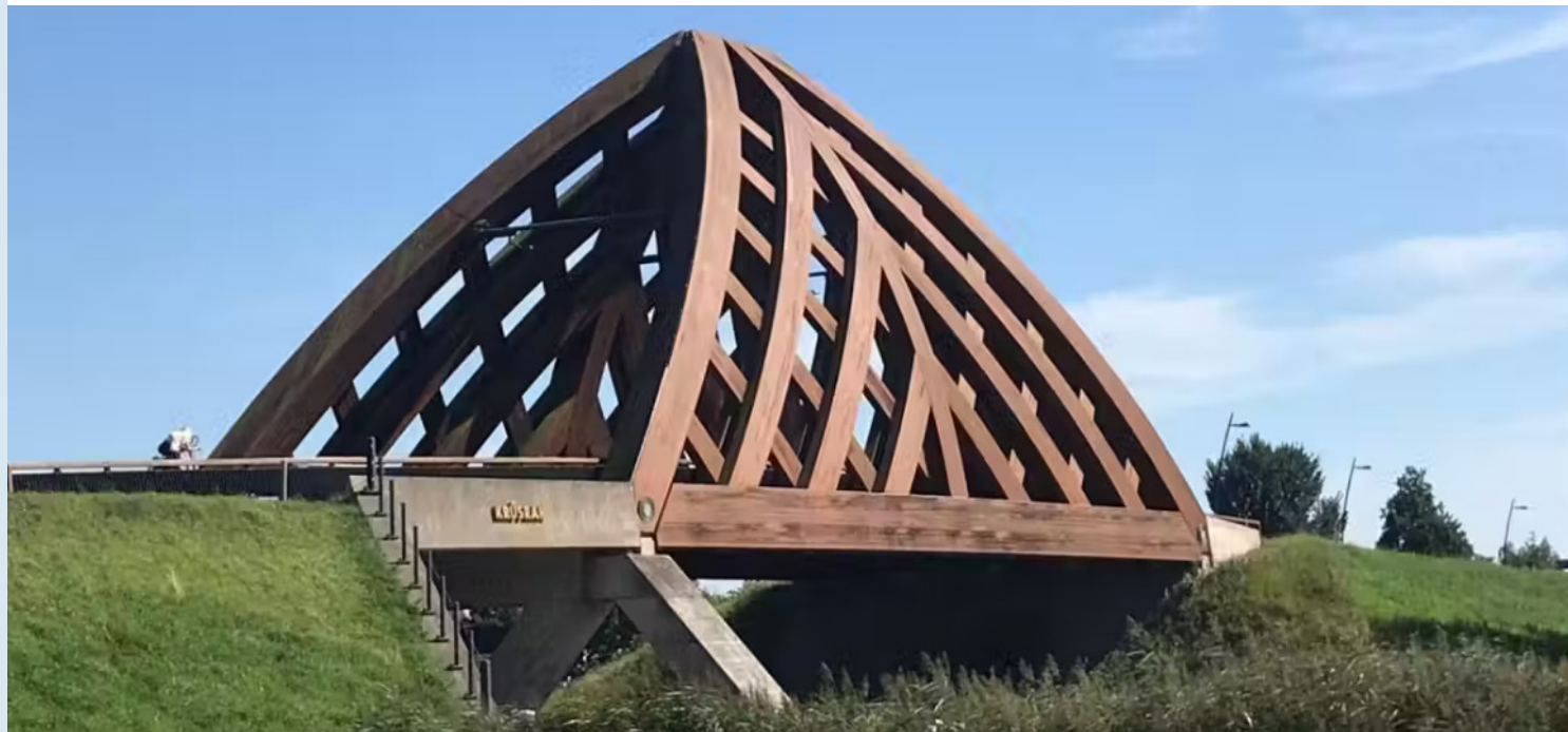
Figuur 6 Brug Sneek (bron: https://www.rijkswaterstaat.nl/nieuws/archief/2021/08/aanbrengen-proefvlakken-op-houten-bruggen-sneek-n7-18-augustus-2021 )
