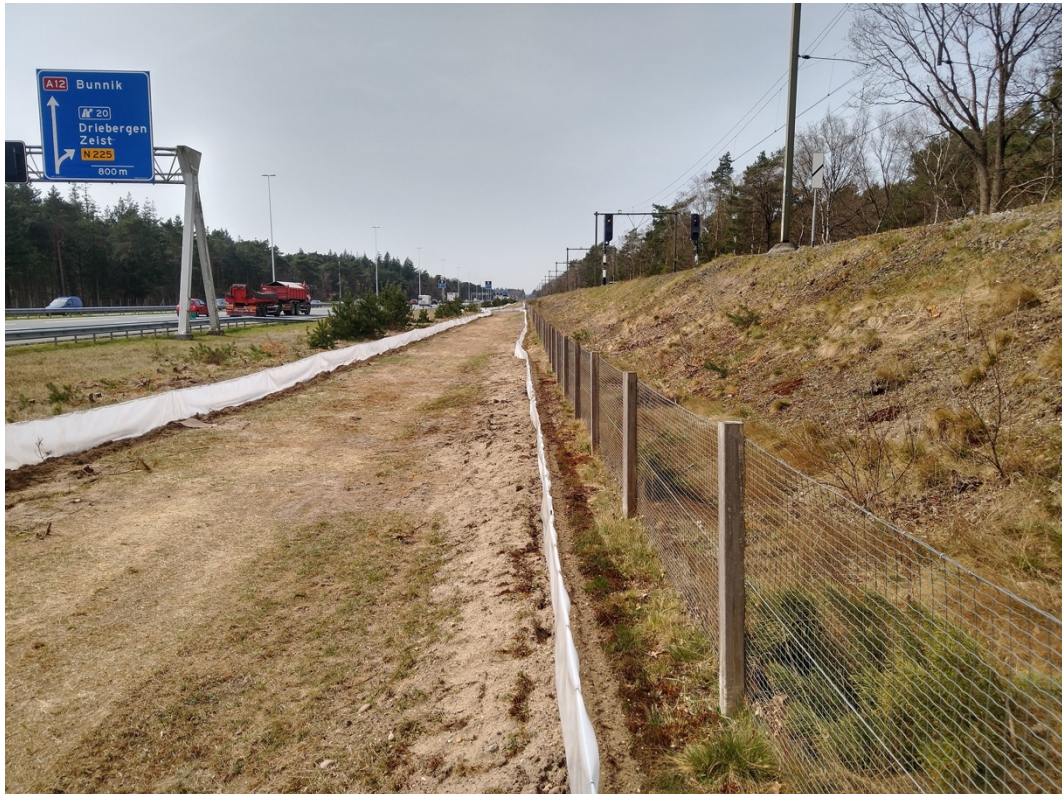
Werkstrook voor de 10kV leiding aan de noordzijde van de A12
