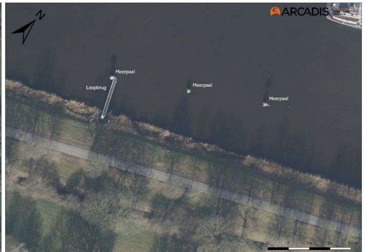
Figuur 2-2 De huidige situatie van het projectgebied met drie afmeerpalen en een loopbrug.
