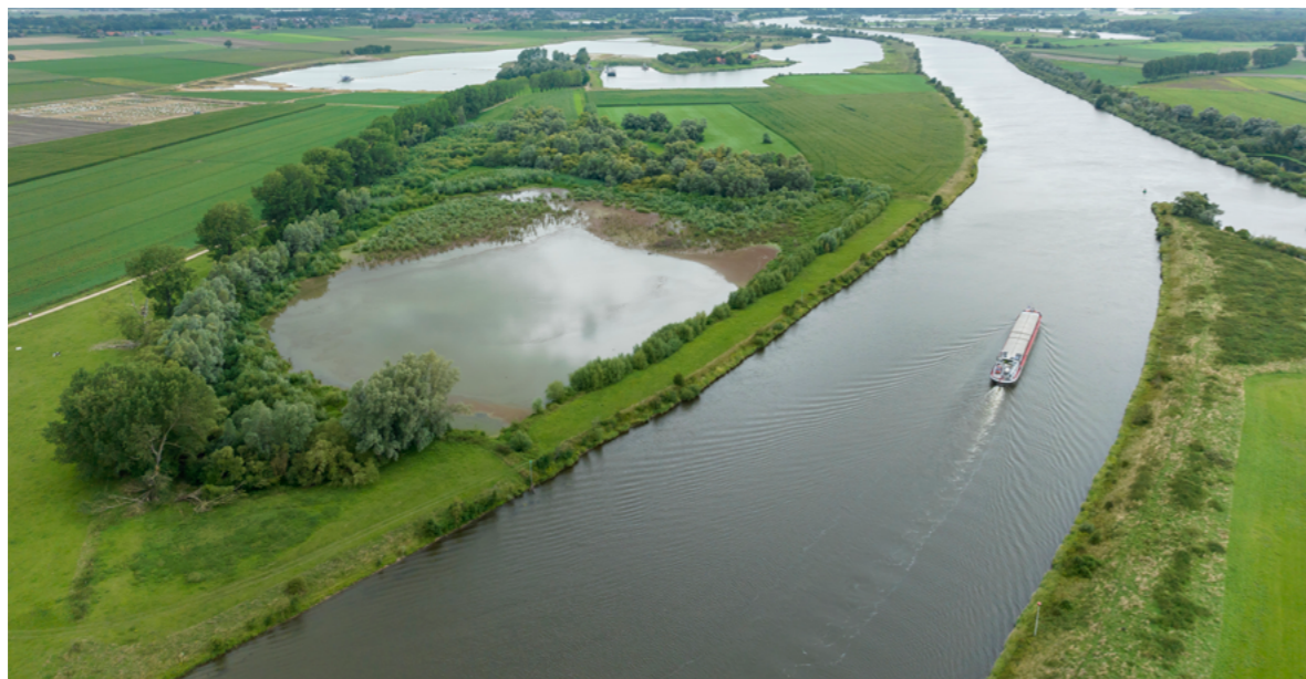
Het maatregelgebied van Oever Bouxweerd op de linkeroever van de Maas. Foto: Studio Retouched
