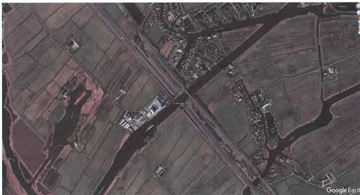
Figuur 1-1 Prinses Margrietunnel.
