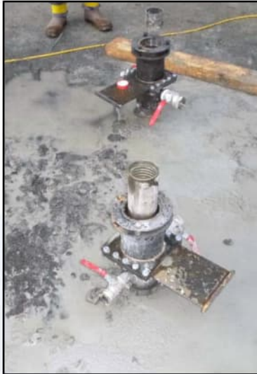
Fig. 6 en 7: Voorbeelden van een eenvoudige sluis voor het uitvoeren van kernboringen resp. een complexere flexibele sluis voor het maken van gewi-palen.
