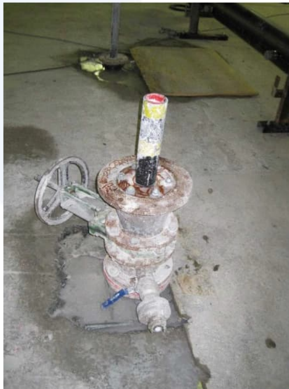
Foto vrieslans na installatie via een sluis
