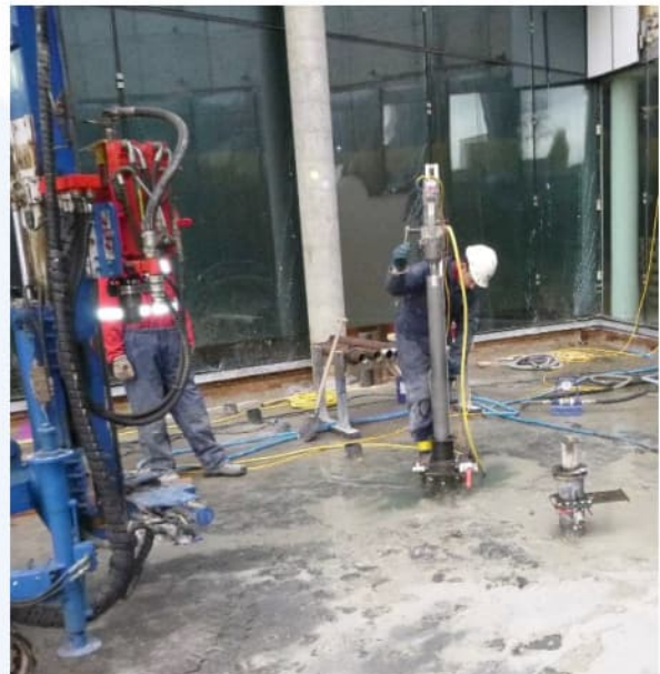
Werksituatie met kernboren door sluis en boren van vrieslansen
