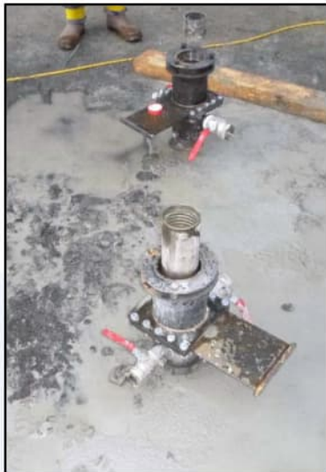
Fig. 6 en 7: Voorbeelden van een eenvoudige sluis voor het uitvoeren van kernboringen resp. een complexere flexibele sluis voor het maken van gewi-palen.
