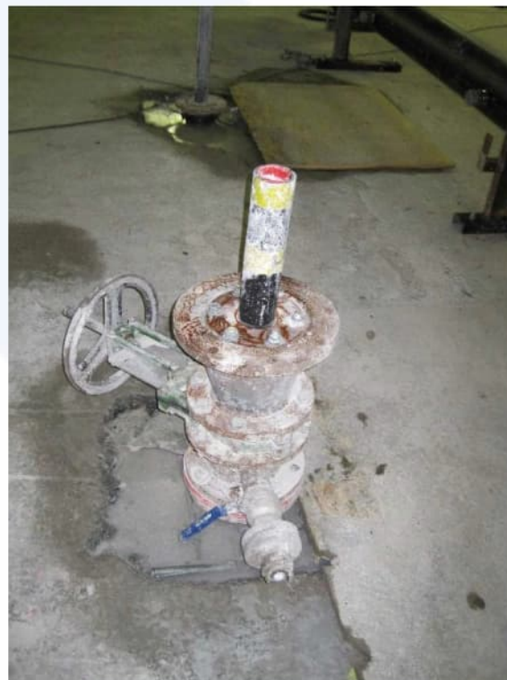
Foto vrieslans na installatie via een sluis
