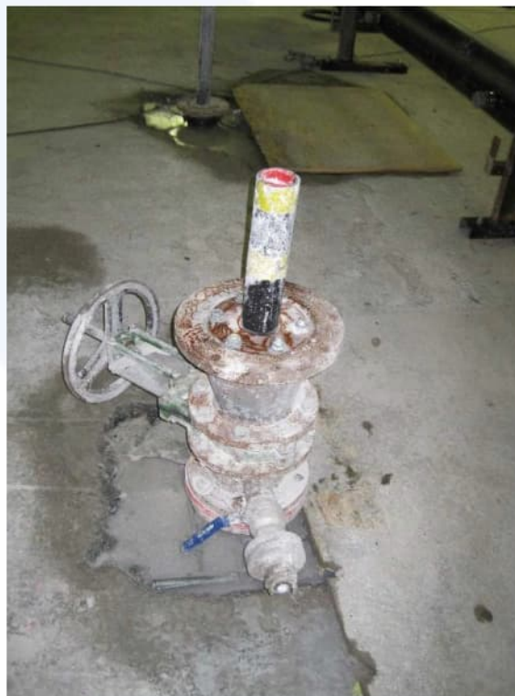
Foto vrieslans na installatie via een sluis
