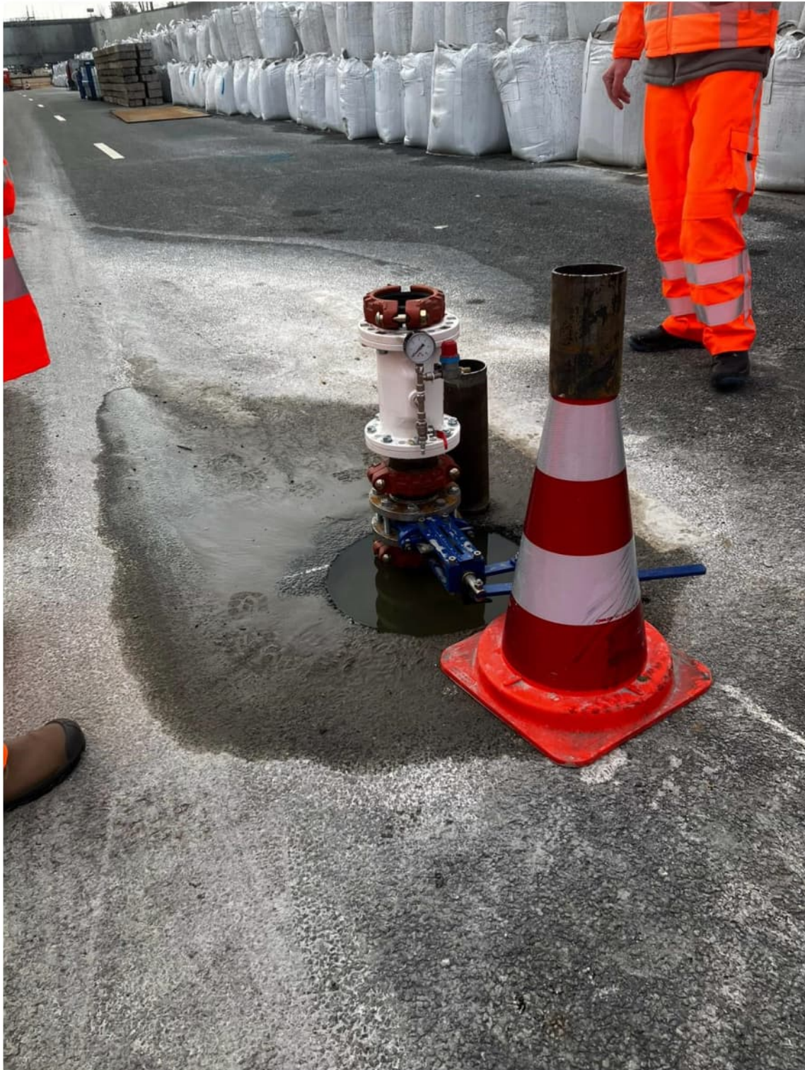
Sluisjesconstructie ten behoeve van de sonderdering door de vloer (tegen de waterdruk)
