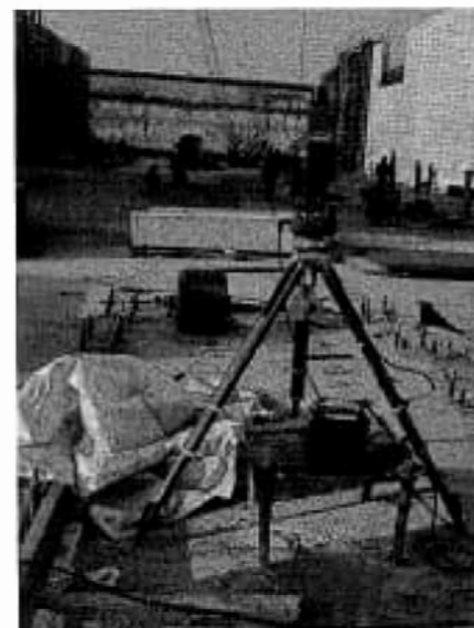
5 Leggen van stalen bodemplaten voor het zinkelement, met behulp van roterende laser Placing the steel bottom plates for the under water tunnel element, with the aid of a rotating laser
