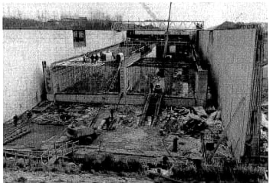
Stand werkzaamheden begin maart 76 Photograph, dated March 1976
