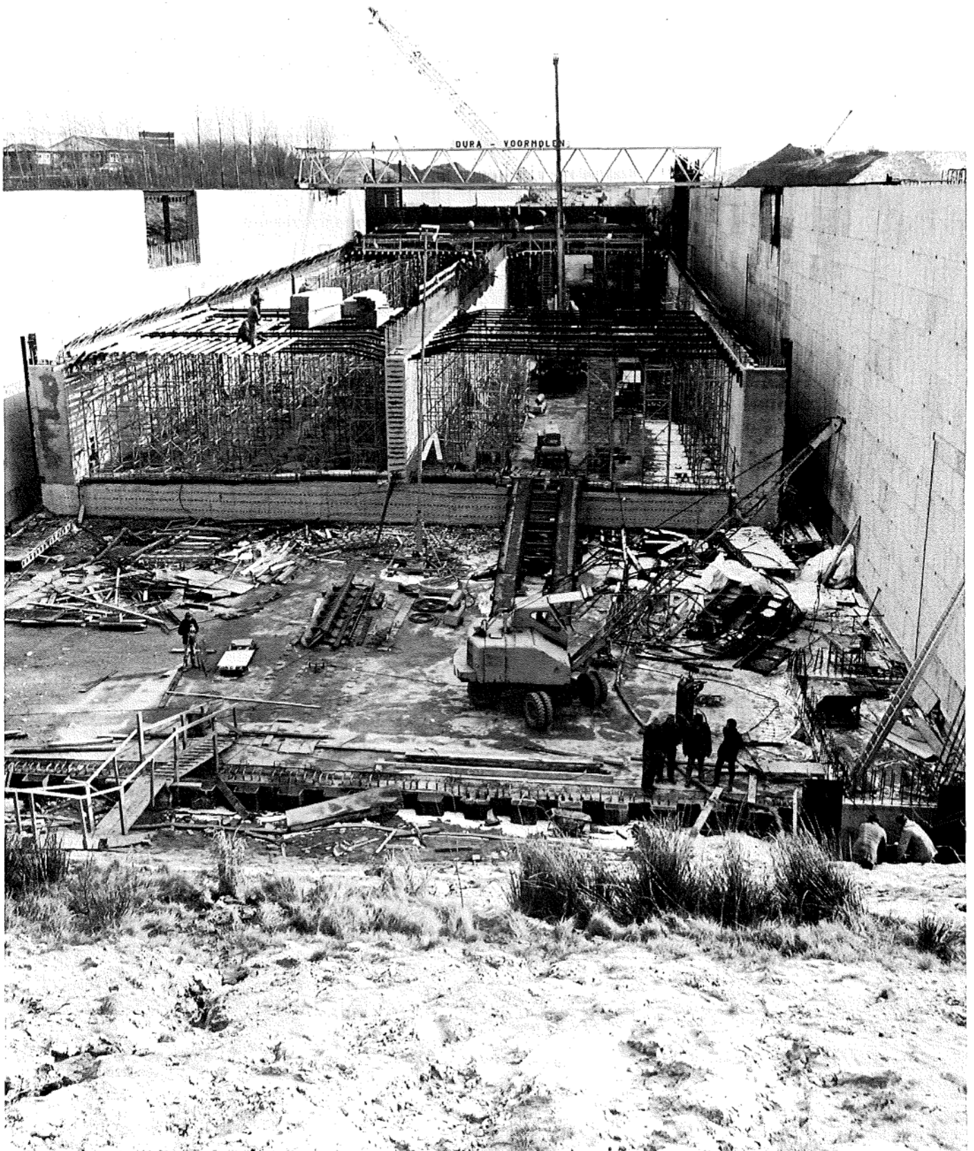
Een bijzondere bouwplaats voor een tunnelement: de aansluitende afrit foto: Cement/Bob de Rutter
