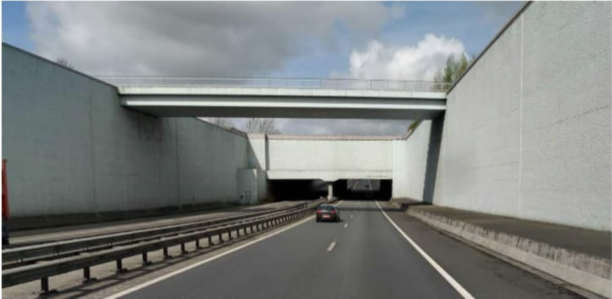
Aquaduct en Viadukt Prinses Margriettunnel gezien vanuit het Zuiden
