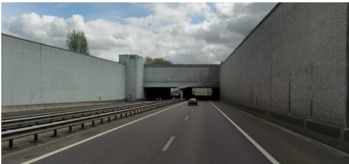
Aquaduct Prinses Margrietunnel gezien vanuit het Noorden
