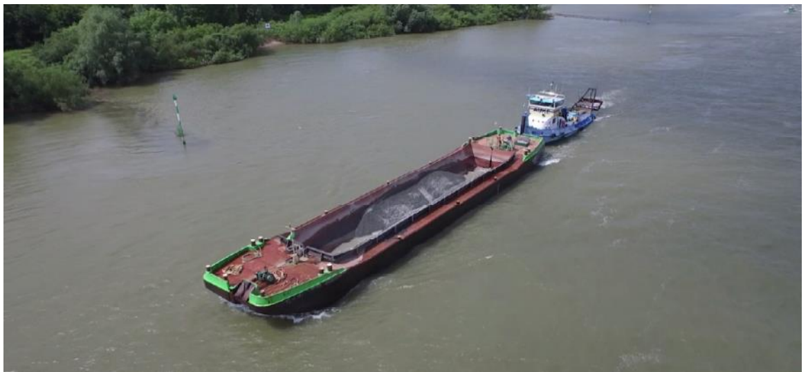
Figuur 9 Uitvoering eerste suppletie op de Boven-Rijn: foto van de uitvoering van de eerste suppletie met splijtbakken en duwboot vanuit de lucht (bron: Weijnans, 2016).
