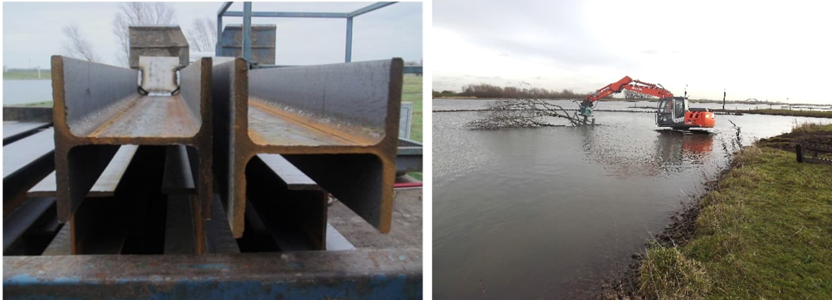
Foto 6 – Stalen H-balken (links) die in de bodem worden getrild (rechts).
