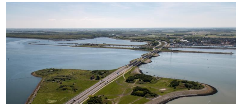
De Stevin sluizen bij en Oever (foto: Ivo Vrancken, bron )
