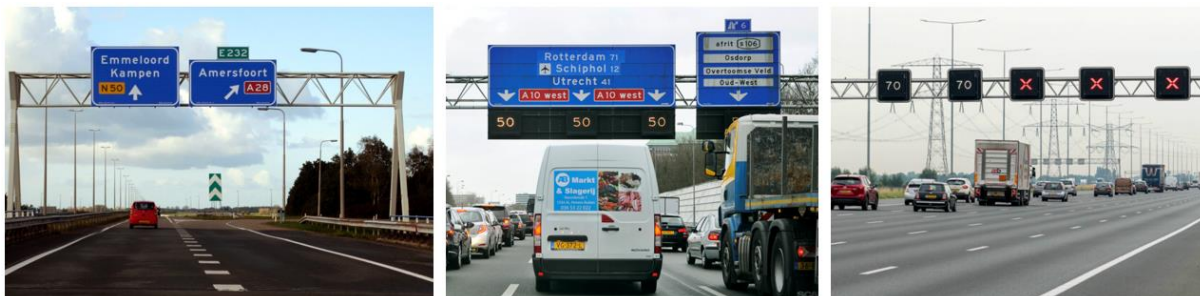
Figuur 1 – Voorbeeld portaal met alleen bewegwijzering (linker afbeelding), dubbelportaal met bewegwijzering en matrixsignaalgevers (middelste afbeelding) en portaal met alleen matrixsignaalgevers (rechter afbeelding)
