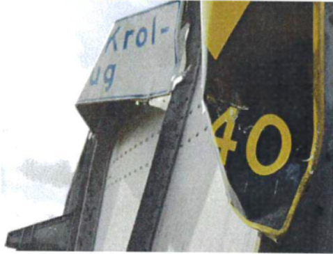
Brugnaambord en doorvaarthoogtebord zijn defect.
