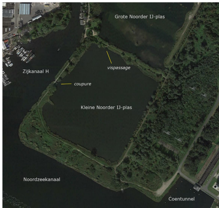
Figuur 1 Ligging Kleine Noorder IJplas aan de noordzijde van het Noordzeekanaal tussen de A10 Coentunnel aan de oostzijde en Zijkanaal H aan de westzijde
