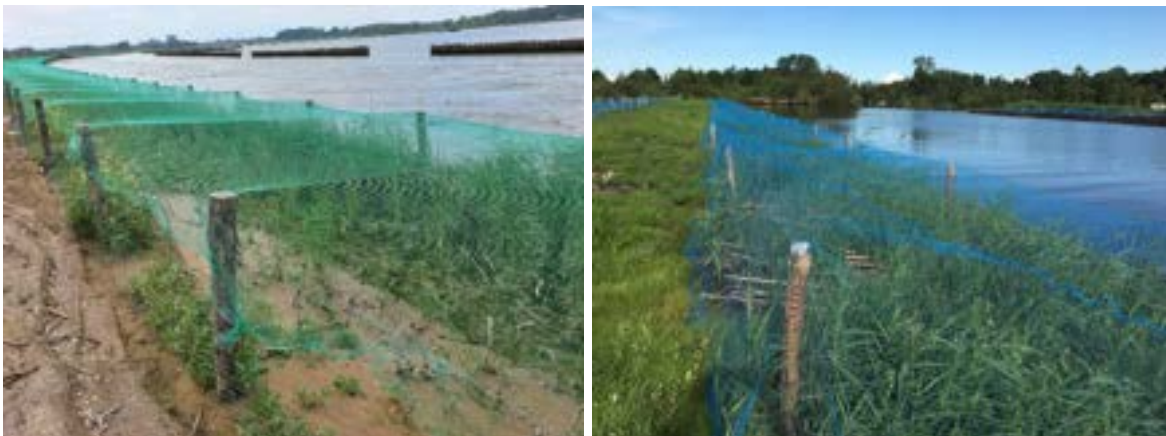
Figuur 4-1 Toepassing van antivraatrasters bij ontwikkeling NVO
