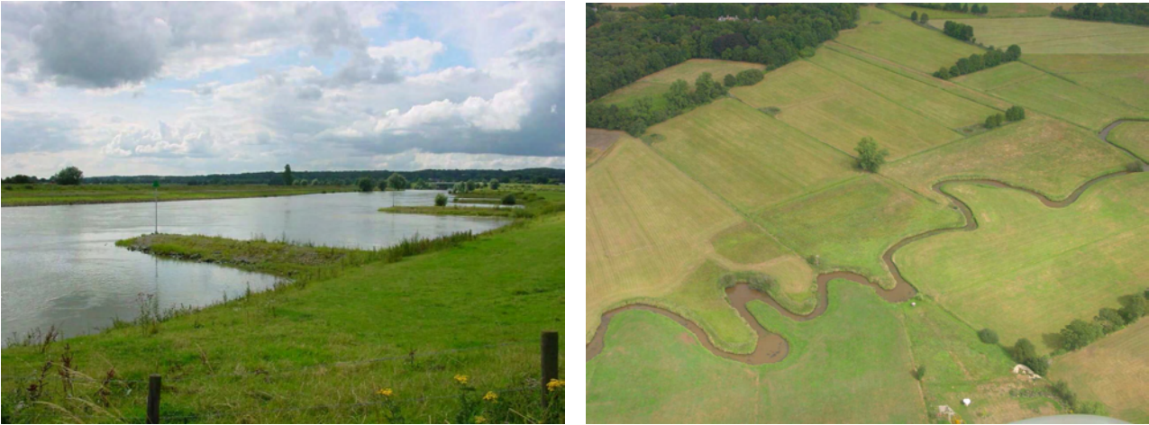
Figuur 3.29 en 3.30 Beperking meandering door kribben en oeververdediging (links, foto: BCC) en vrije meandering van de Reest in het beekdal (rechts, foto: waterschap Reest & Wieden).
