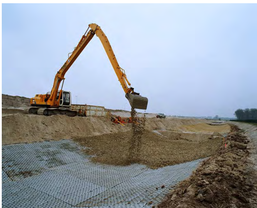
Figuur 3.20 Kunstmatig beddingmateriaal wordt aangebracht in de Grote Molenbeek (Foto: beeldbank RWS).
