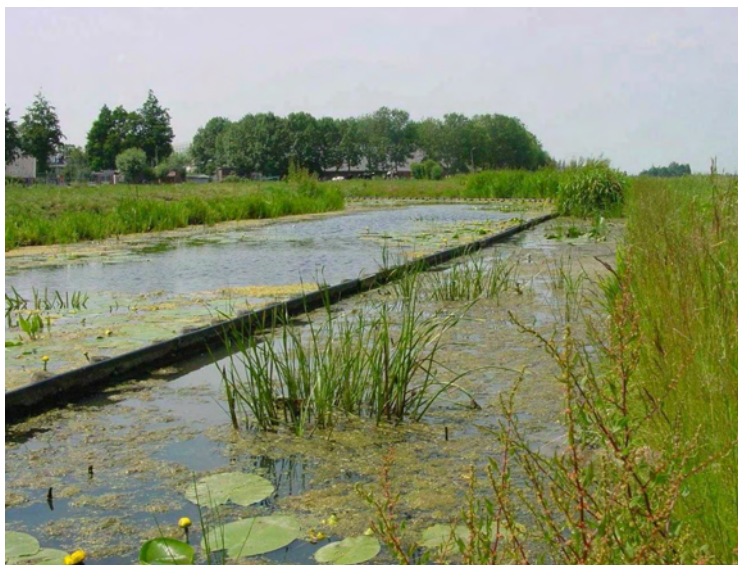
Figuur 3.24 Vooroeververdedigingen. (foto Ing. BCC)
