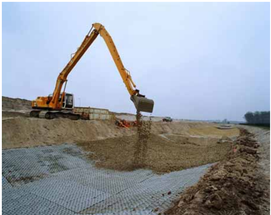
Figuur 3.20 Kunstmatig beddingmateriaal wordt aangebracht in de Grote Molenbeek (Foto: beeldbank RWS).
