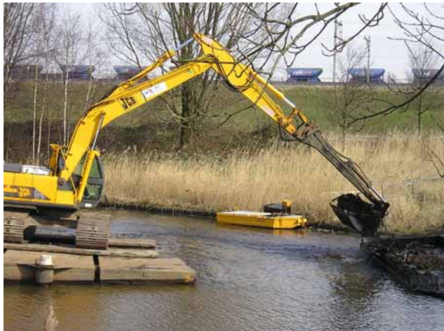
Figuur 4.13 Waterbodemmonsters kunnen goed tijdens baggerprojecten worden genomen (foto: Ing. BCC).
