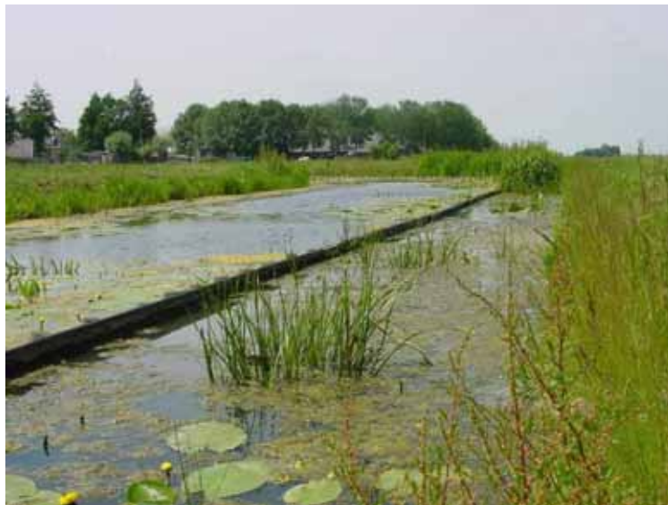
Figuur 3.24 Vooroeververdedigingen. (foto Ing. BCC)
