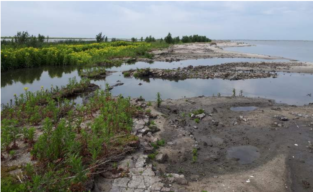
Figuur 1.2 Foto van nieuwe doorgang (april 2022)
