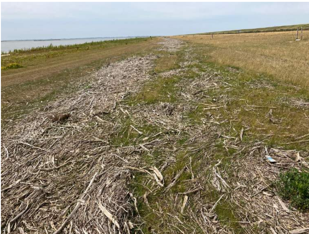
Figuur 3.3 Aanspoelgordel Markermeerzijde
