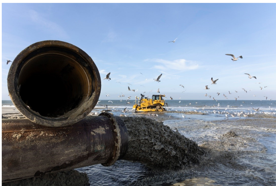
Figuur 1. Uitvoering van een strandsuppletie (bron: Rijkswaterstaat).
