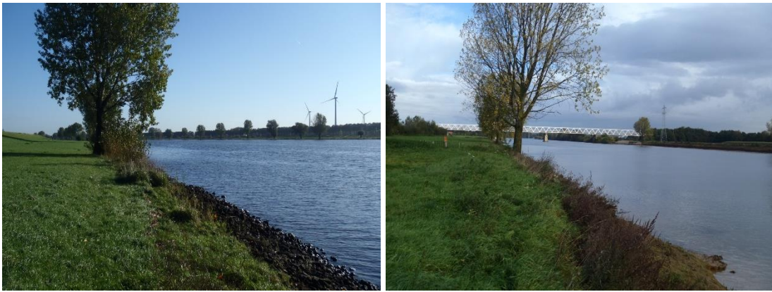
Figuur 3.5 Reguliere oever met stenen oeverbekleding, de bovengrens van de oever ligt daar waar een gesloten grasmat of waar ruigte aanwezig is.
