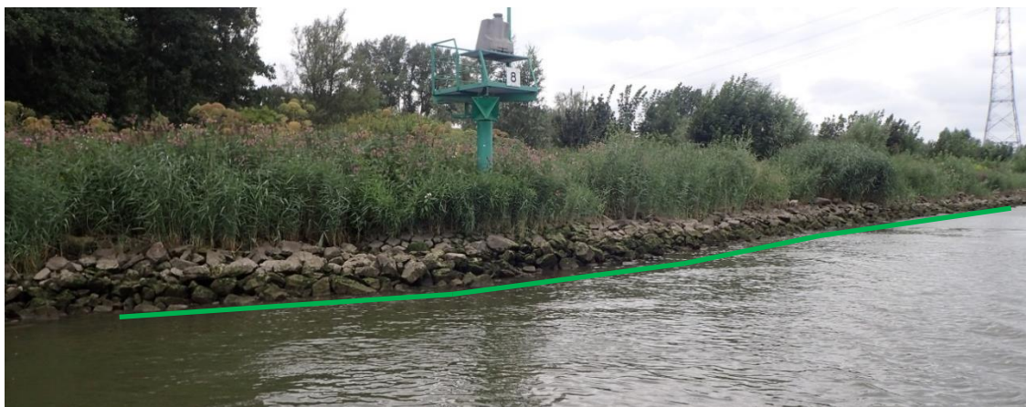
Figuur 3.2 Zonering van de oever in getijdewateren, de groene lijn is de GLW (gemiddelde laagwaterlijn).
