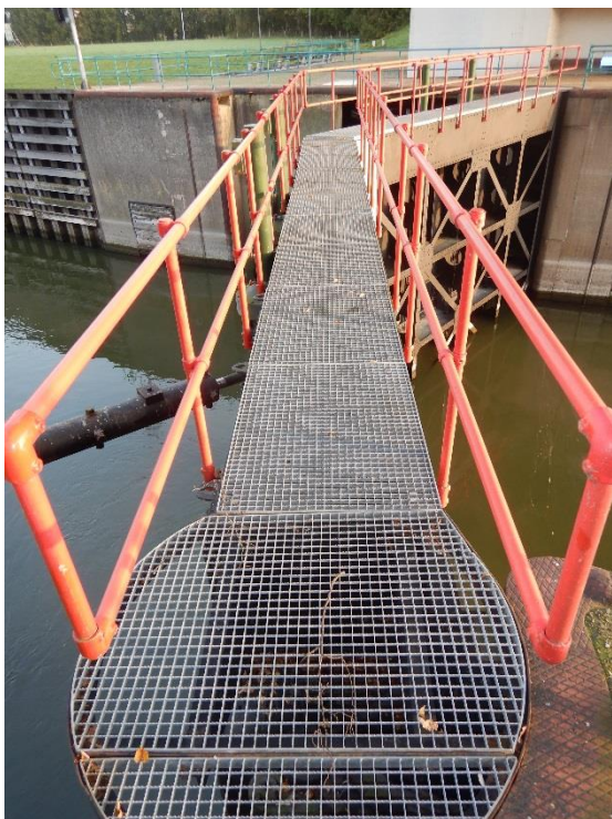
Roostervloer en leuningwerk
