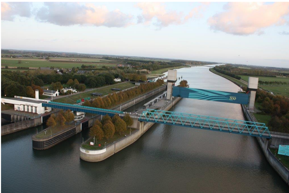
Afbeelding 3.1 Prinses Marijkesluis (2 kolken links, rechts keerschijf) 2
