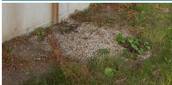
Hemelwater wordt geloosd op maaiveld middels grindkoffers
