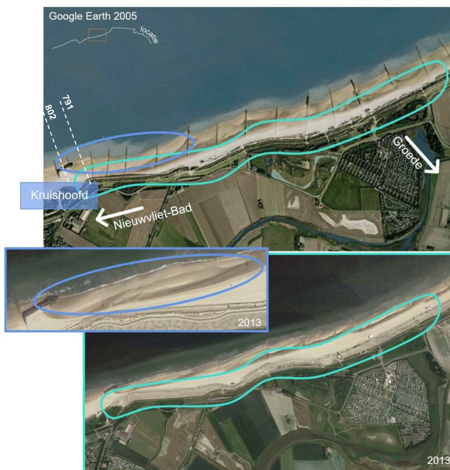
Figuur 5-11; Overzicht van de Zwakke Schakel versterking bij Nieuwvliet-Groede in 2009. De paarse kleur geeft de locatie van de erosieberm weer, en de groene de duinversterking (Vermeer en van der Werf, 2022).
