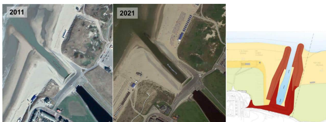
Figuur 2-19 Uitwateringssluis bij Katwijk in 2011 (links), in 2021 na verlenging met 50m (midden) en het ontwerp van de verlenging (rechts). Bron: Google Earth en Arcadis (2013)
