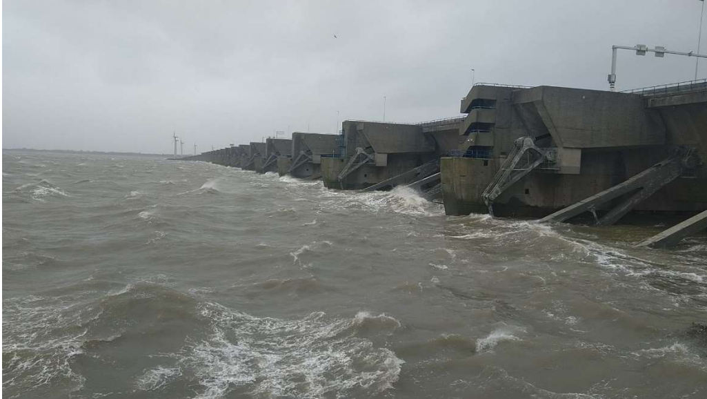
Figuur 29: Haringvlietsluizen in stormsluiting, Foto RWS West Nederland Zuid
