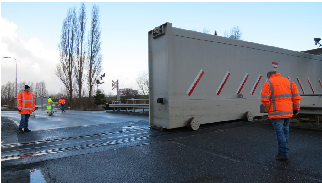
Figuur 11 Sluiting noordelijke coupure Delfzijl op zondag 11 januari
