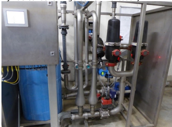
figuur 11: Vortex-installatie (rechts van het blauwe vat zijn de conusvormige buizen zichtbaar)
