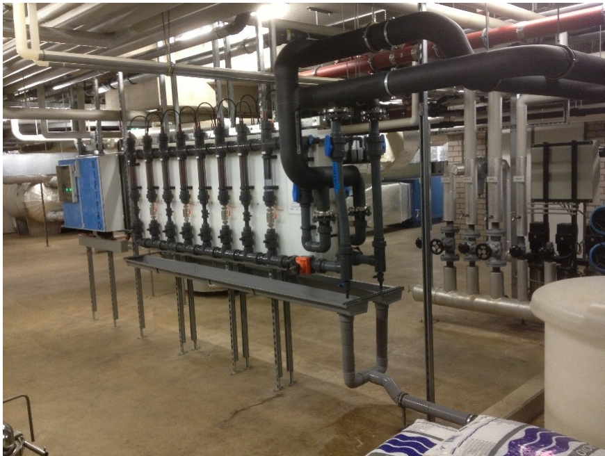
Figuur 10: installatie Cu/Ag-ionisatie (bron: Holland Water 2021)
