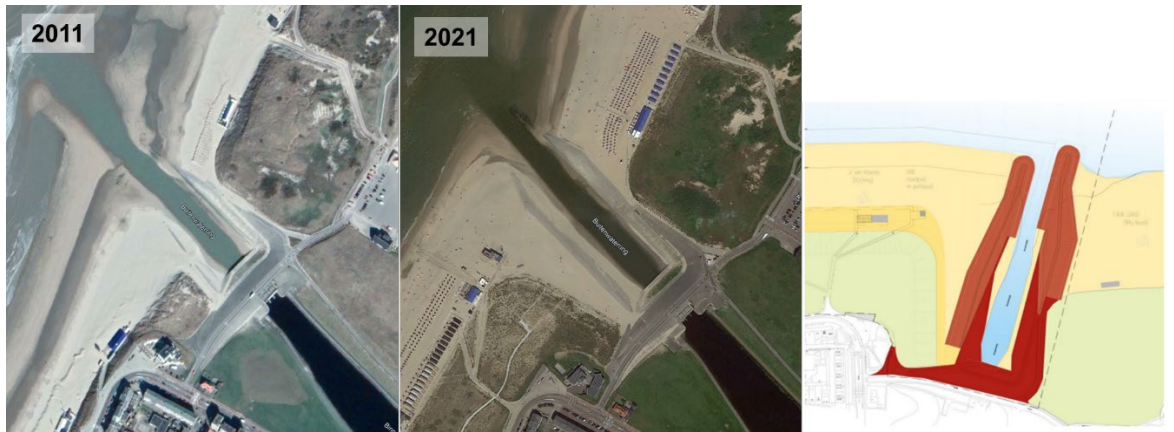
Figuur 2-4 Uitwateringssluis bij Katwijk in 2011 (links), 2021 na verlenging met 50m (midden) en het ontwerp van de verlenging (rechts). Bron: Google Earth en Arcadis (2013)
