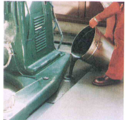
PCI Repaflow vloeit gemakkelijk en vult horizontale holle ruimtes vanzelf.
