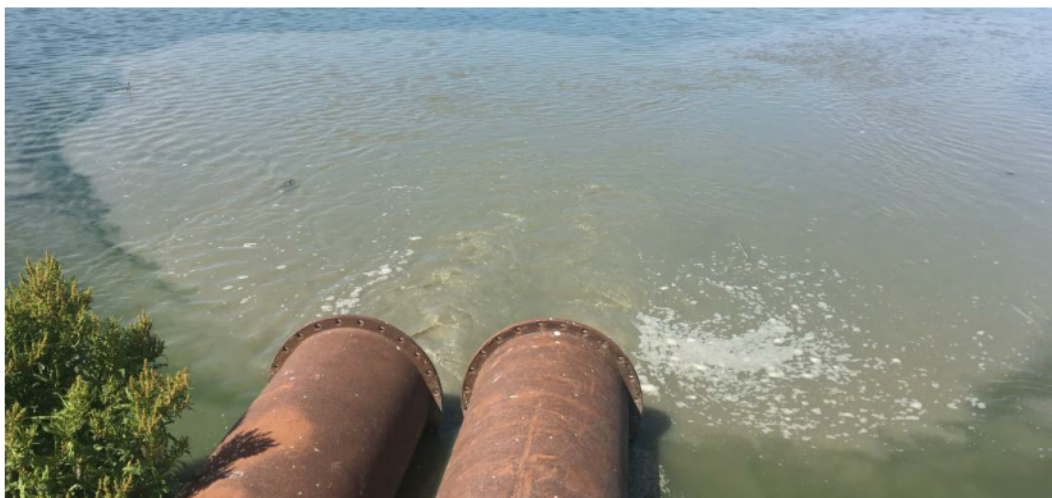
Door werkzaamheden is er nog te veel omwoeling (foto: [redacted]).
