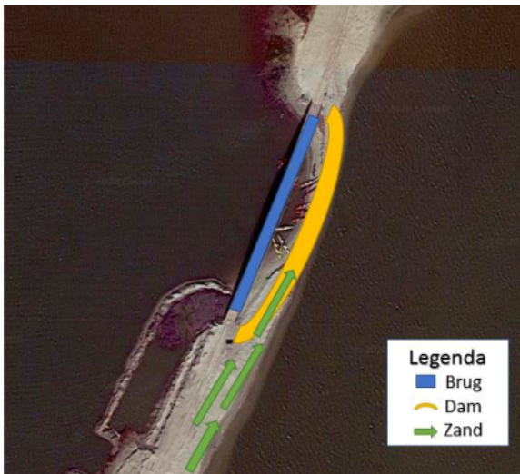
Figuur 3. Luchtfoto ter plekke van de brug
