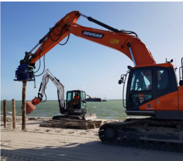
Figuur 7. Referentie voor plaatsen paal met trilblok
