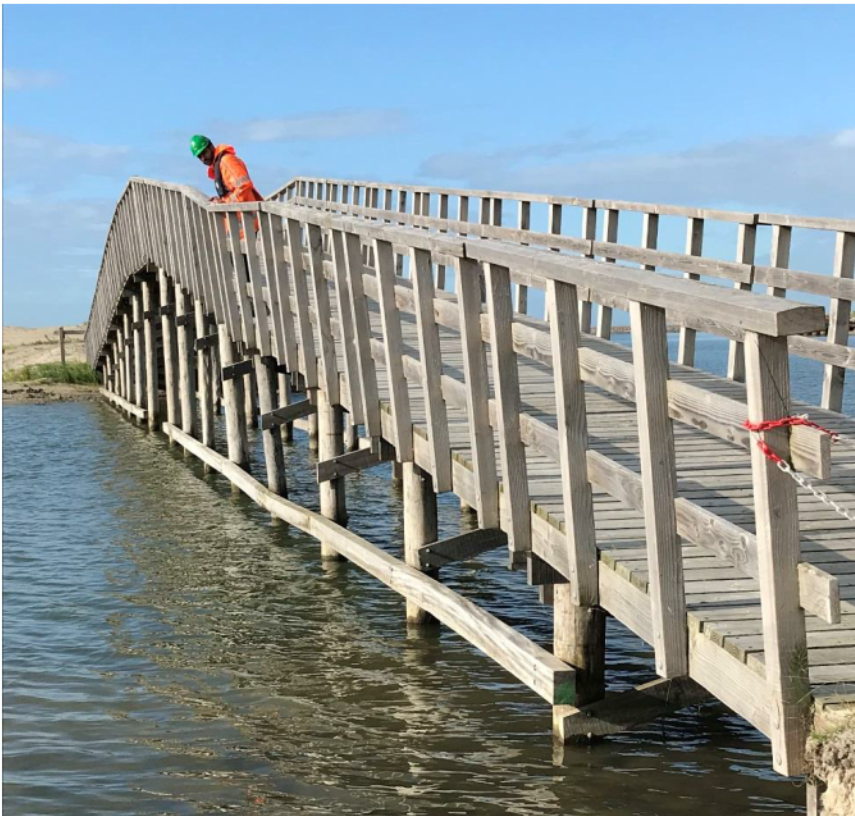
Figuur 2. Huidige situatie brug
