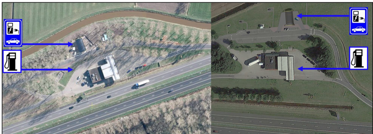
Afbeelding 4 Recentelijk gerealiseerde oplaadstations naast tankstation (links Lageveen-A28, rechts Broerdijk-A7)
