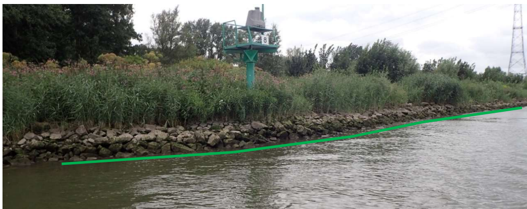
Figuur 3.3 Zonering van de oever in getijdewateren, de groene lijn is de GLW (gemiddelde laagwaterlijn).
