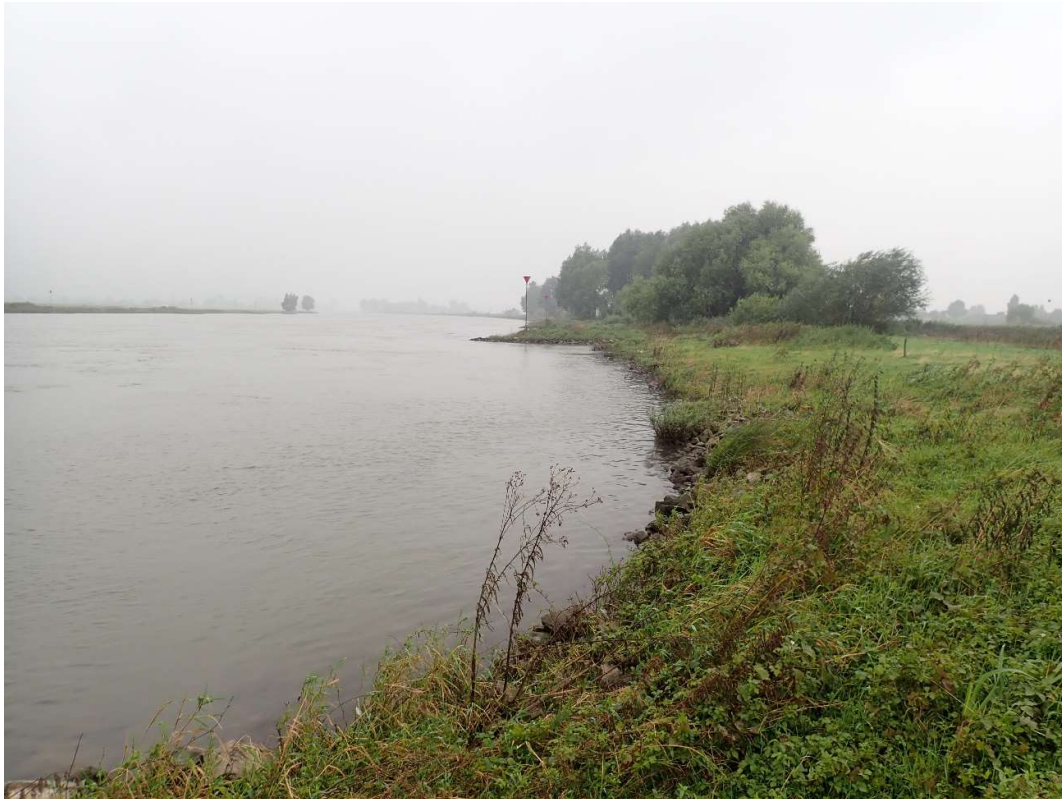
Figuur 4.10.1. Voorbeeld van een meetlocatie in de IJssel (overzichtsfoto meetlocatie OLDENL1 op 19 augustus 2021).
