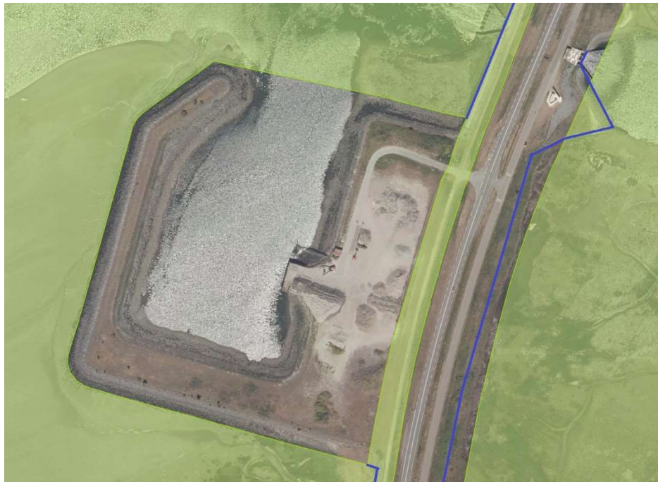
Figuur 2e Haventje bij Rammegors. Dit is een voorbeeld dat bij havens de dijk veelal niet bij het habitatgebied hoort (ook bij Bruinisse is een dergelijk voorbeeld). Gek genoeg hoort de achterliggende grazige berm aan beide zijden van het fietspad (gele strook) weer wel tot het habitatgebied. Aan de oostzijde van de autoweg is juist weer te weinig habitatgebied aangewezen, waardoor een rand van de kwelder (H1330) niet tot het habitatgebied behoort. De blauwe lijn geeft een voorstel tot verbetering.
